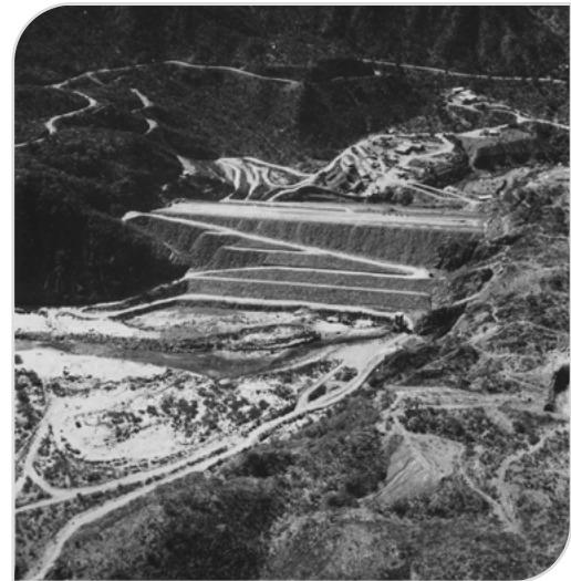
Ogas, D. y Reynoso, N. (2009). Dique las Pirquitas. San Fernando del Valle de Catamarca, Arg.: Sarquís
