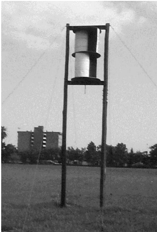
Fig. 4.34. Colector de tipo Savonius que está bajo experimentación en la Facultad de Arquitectura y Urbanismo de la UNT. (Geréz M., Tortonese A. y G.E.Gonzalo, 2000)
