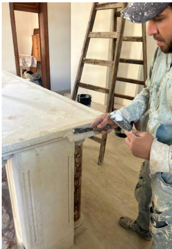
Reposición de molduras en altar original de la iglesia.
