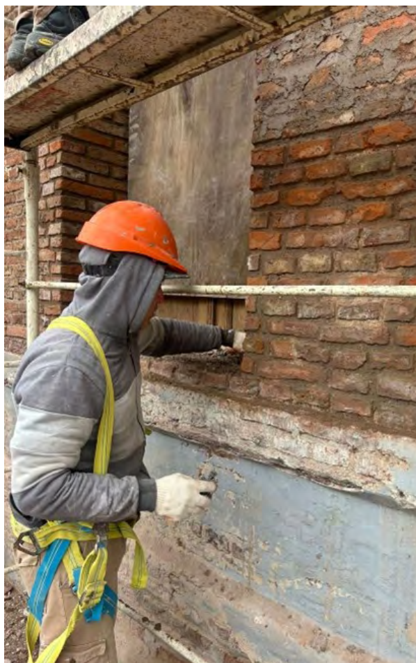
Trabajos de reposición de juntas, liberación de revoques no originales.
