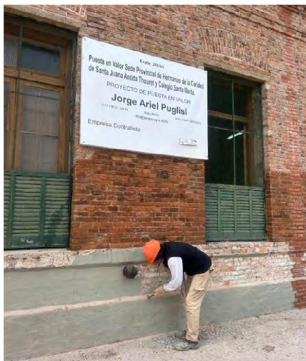
Trabajos de reposición de juntas, liberación de revoques no originales.
