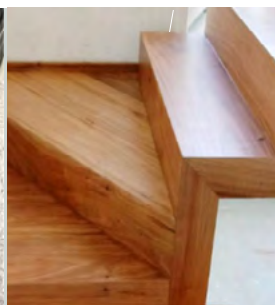
ENTREPISOS, ESCALERA Y BARANDAS
