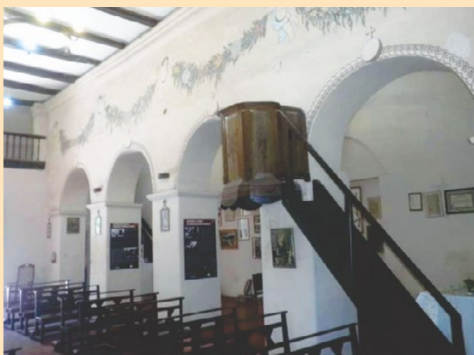
Vista del sistema estructural que divide las naves, con el púlpito como elemento protagonista.
