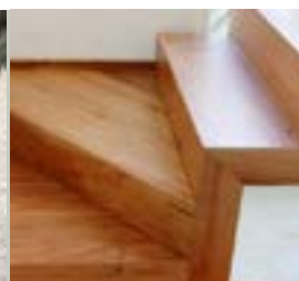
ENTREPISOS, ESCALERA Y BARANDAS
